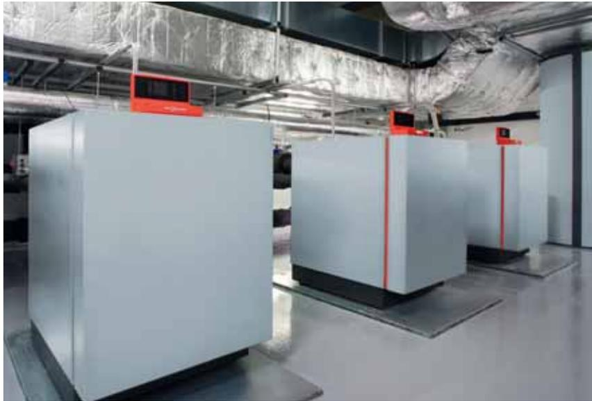
Sole/Wasser-Wärmepumpe Vitocal 300-G
